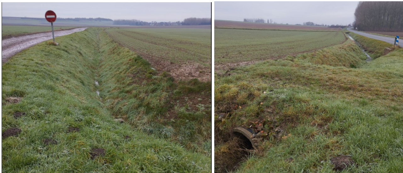
Figure 12. Prises de vue du fossé agricole en amont OA
