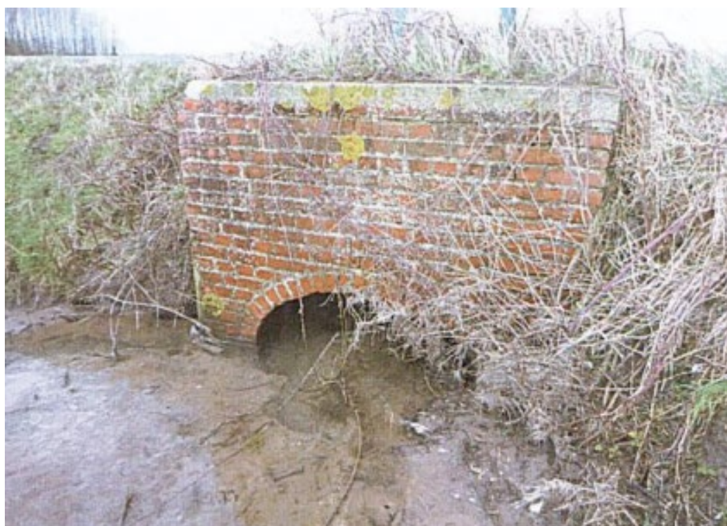
Figure 2. Prise de vue aval et amont actuel du busage OA1699
